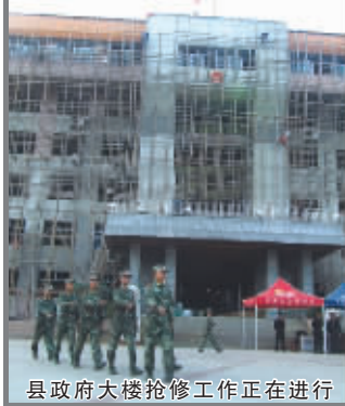
县政府大楼抢修工作正在进行
