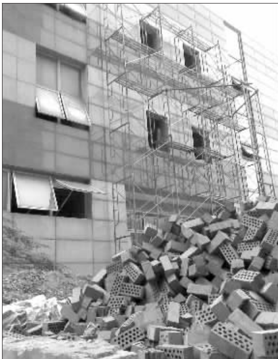
被业主推倒的墙,远处可见外立面上钻出的四个窗户
