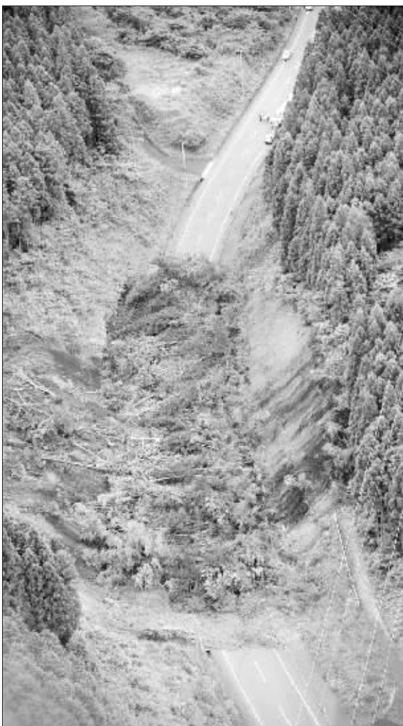
公路在地震中因塌方而损毁 新华社/路透
