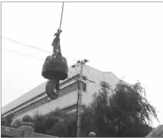
高压线位于桥面斜上方 快报记者 薛林 摄
