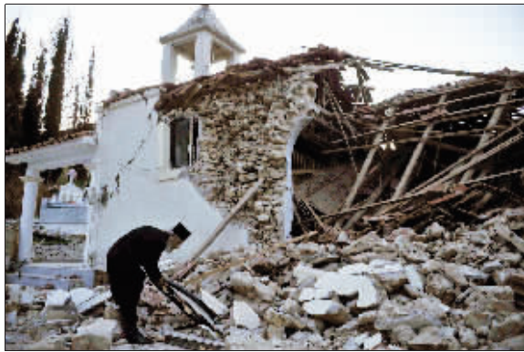
一名牧师在清理一座房屋倒塌后的废墟 新华社/法新
