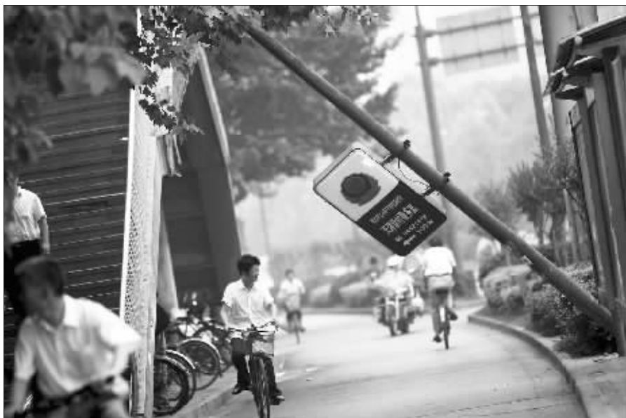
昨天,在南京虎踞北路上,一根约7米高的电线杆斜靠在旁边的天桥上,过往的市民纷纷避让。
