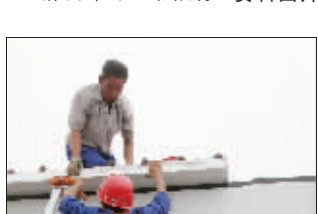
精心施工确保质量 新华社图片
