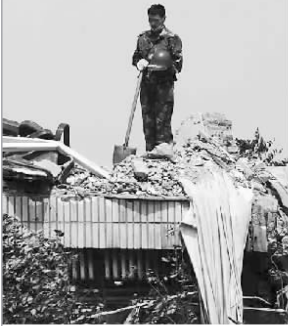
5月19日14时28分,在四川省绵竹市汉旺镇一处被破坏房屋的屋顶上,一名救援人员停下手中的清理工作,为汶川大地震遇难同胞默哀。 新华社记者 王建华 摄
