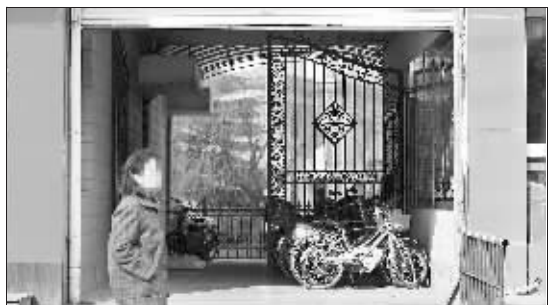
律师小区维权正是为了这个消防通道 施向辉 摄
