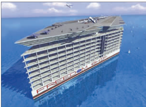
“自由之船”的顶端是大型机场跑道
