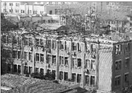
东南大学动力楼为木顶的四层楼房,此次过火面积达1000多平方米。
