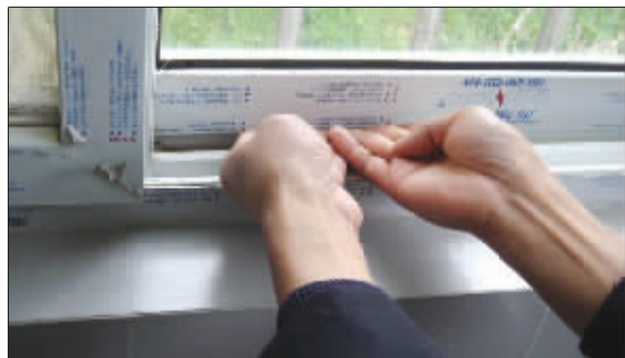
塑钢窗关不严，缝隙可插进手指
