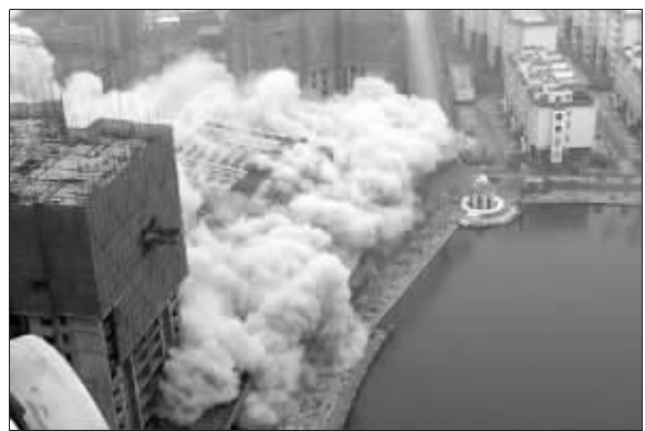
两栋在建楼盘被实施强制爆破
