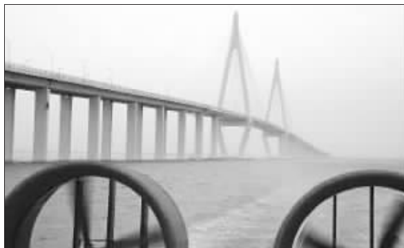
钻石形双塔威风地矗立在主航道上
