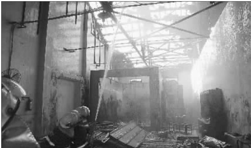
消防队员正在老厂房里扑火 快报记者 薛林 摄
