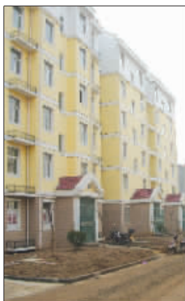
一楼安防措施不到位
