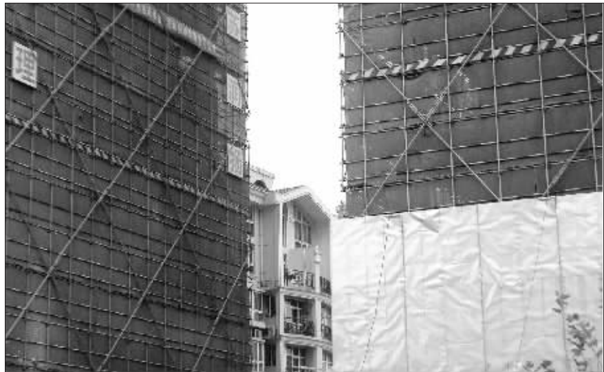
两幢小高层紧挨着居民楼
