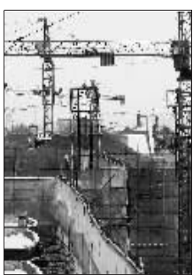
经适房建设现场
