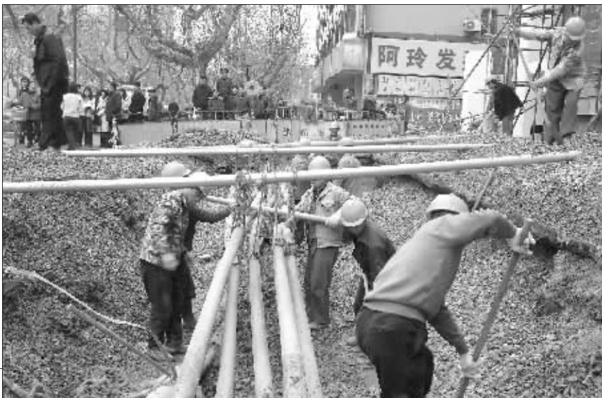
工人们正紧张修建管线渠道
