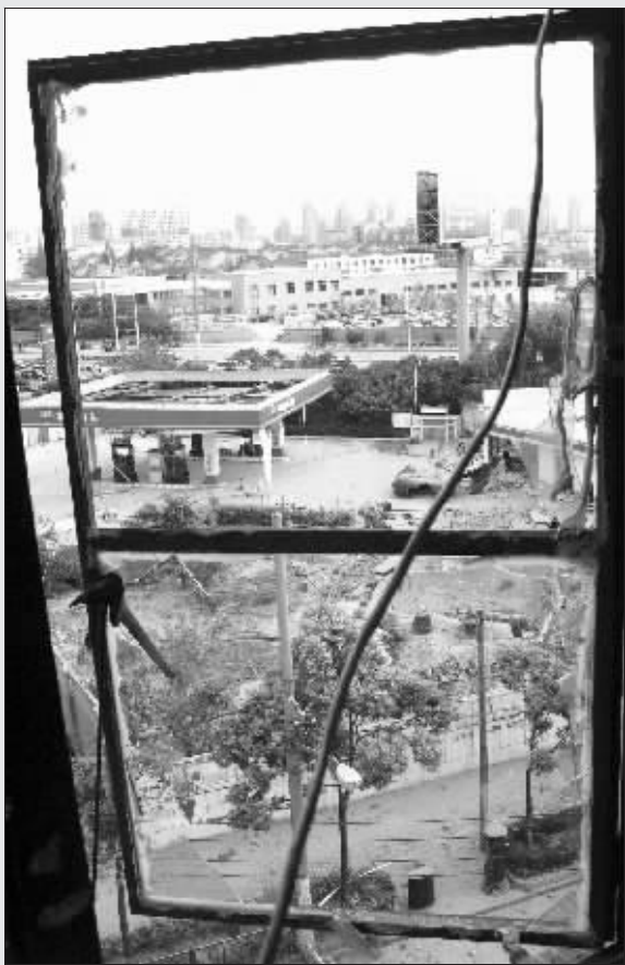
加油站附近大楼窗户玻璃被震碎
