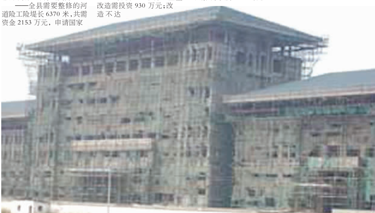
正在建设中的固始县行政中心 肖波 王文志 摄
