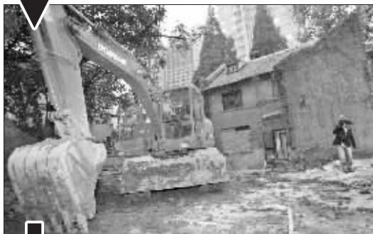
一台挖掘机停在公馆内
