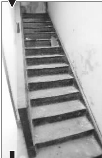
公馆楼梯保存尚且完好
