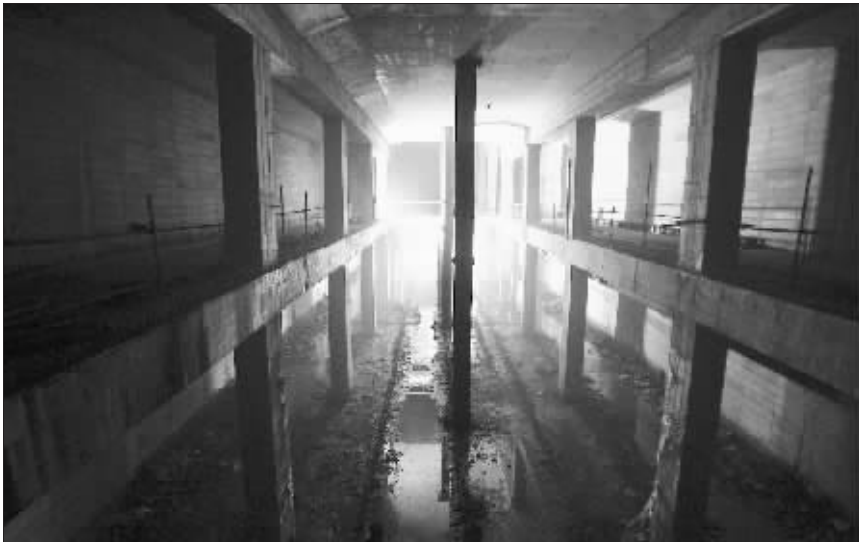
苜蓿园站主体结构已经完工 快报记者 顾炜 摄
