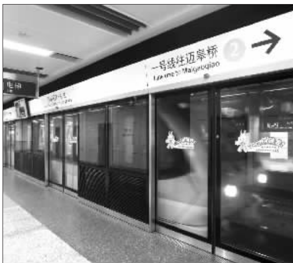
近日,地铁部门在抓紧调试中胜站安全门(半封闭式)和地铁列车的信号对接。今后安全门与列车门将同时自动开启,试点成功的话,其余15个站点年内有望分批安装安全门。快报记者 顾炜 摄
