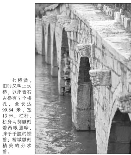
七桥瓮, 旧时又叫上坊桥。这座青石桥有7个桥孔, 全长达99.84米, 宽13米, 栏杆、桥身两侧雕刻着两眼圆睁、胖乎乎脸的怪兽; 桥墩雕刻精美的分水兽。
