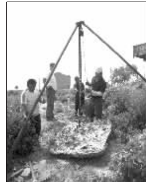
架起三角架吊起铁块
