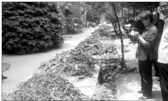
管子还没埋完,工人就撤了
