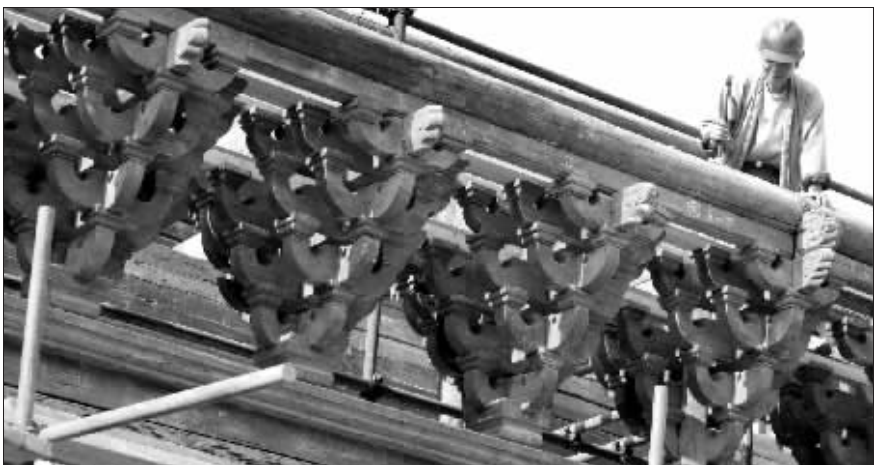
昨天,复建的二公祠大梁正式就位 快报记者 施向辉 摄
