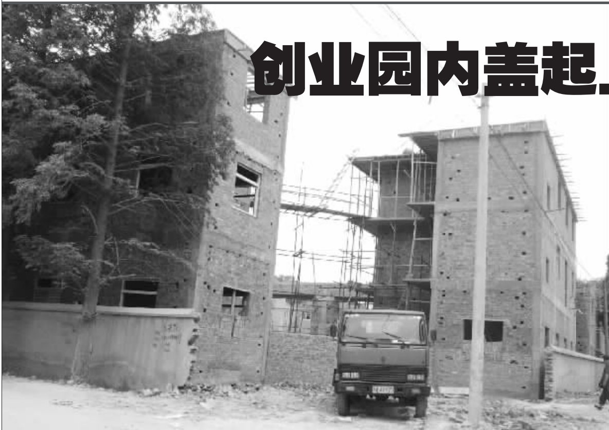
◀违建楼房已砌到第三层 快报记者 薛林 摄
