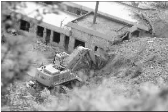
挖掘机不停地工作
