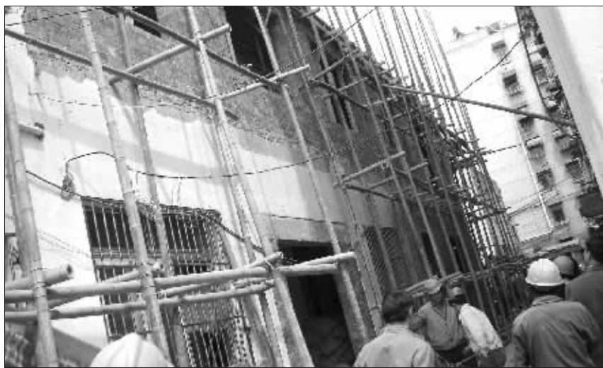
办公楼已经盖到了第二层
