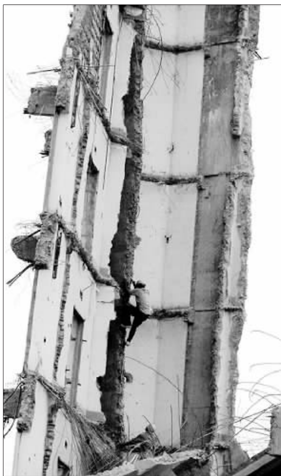
工人爬上断墙重新系上钢缆
