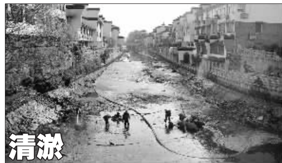
清淤 昨天,几名工作人员正在南京秦淮河内清理淤泥。桃叶渡至西水关的秦淮河因远离“源头活水”,容易造成淤泥堆积,大大影响了水质。此次清淤工程是将此段的秦淮河水抽干,进行一次彻底的清淤,让南京秦淮河又见碧波清水。 快报记者 施向辉 摄
