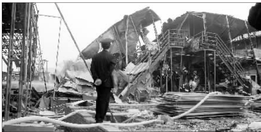
火灾现场,工地宿舍烧得面目全非。快报记者 李绍富 摄
