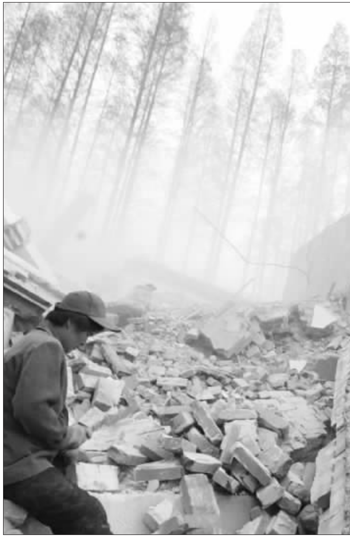
南京的一处拆迁工地上,粉尘缭绕。快报记者 施向辉 摄
