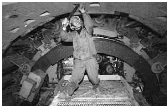
工人正在给盾构机安装管片。 快报记者 齐天天 摄
