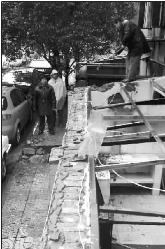
执法人员正在拆除违建 快报记者 翁叶俊 摄
