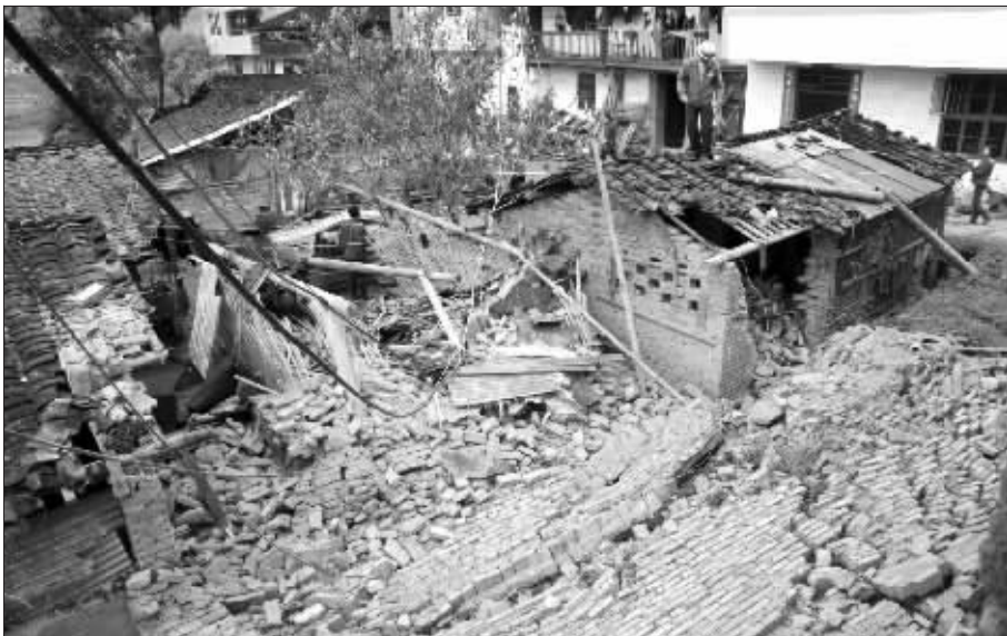
地震现场有房屋被震倒
