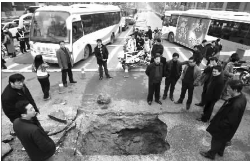
昨天上午7点多,汉中路和上海路的十字路口处又发生路面塌陷 快报记者 翁叶俊 摄
