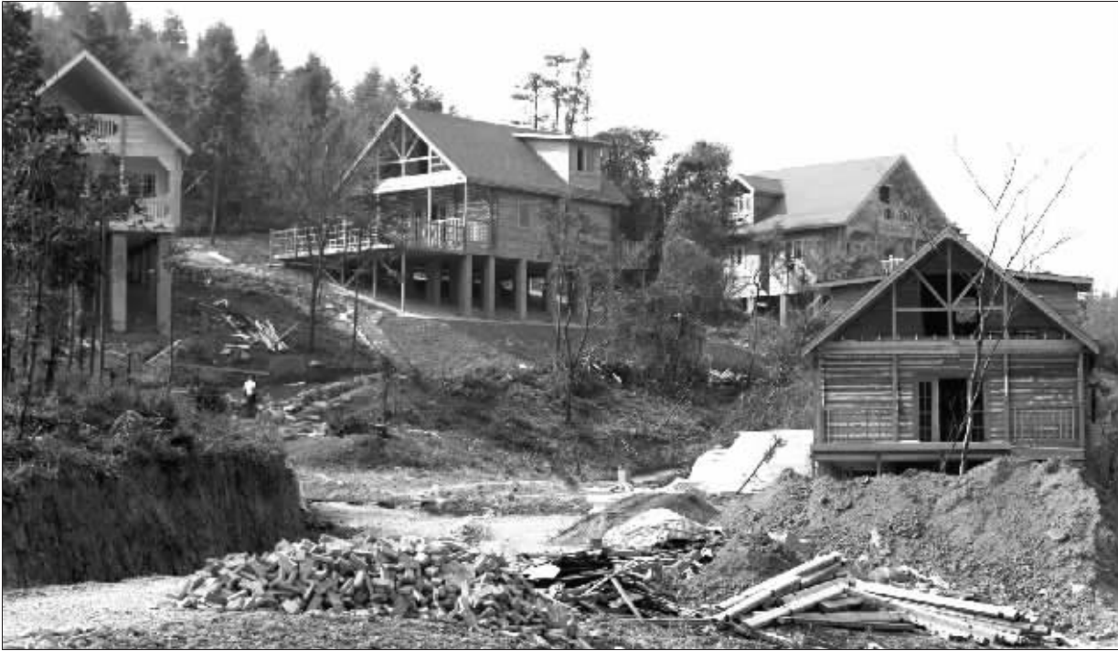
甘泉湖景区内正在建设中的“别墅”。 快报记者 顾炜 摄
