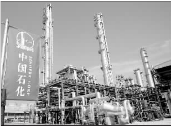
中国石化等权重股的持续调整对大盘形成较大压力 资料图片
