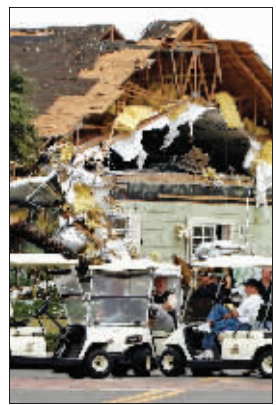
居民在受损的房屋旁
