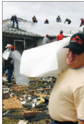
居民修葺损坏的房顶
