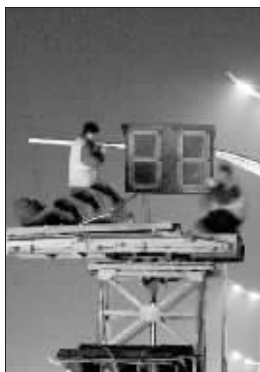
27日 1时 30分: 第3根信号灯杆安装
