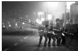
27日 4时 10分: 第6根信号灯杆安装
