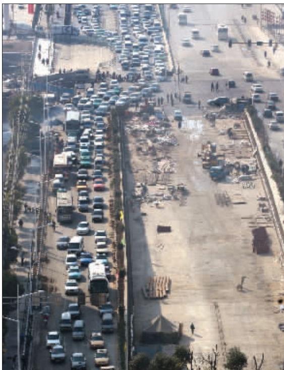
大型道路施工给交通带来很大压力 (资料图片)
