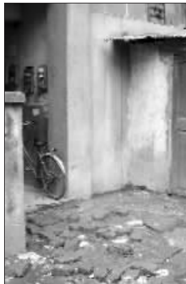
楼梯口被粪便和垃圾包围
