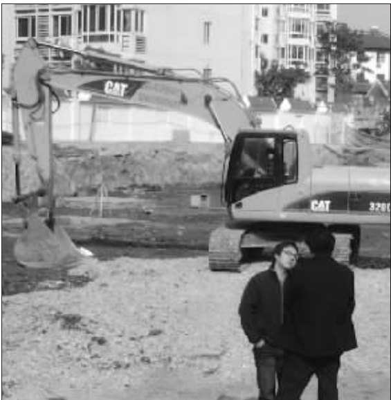
工地出土文物的地方被石子掩埋 快报记者 薛林 摄
