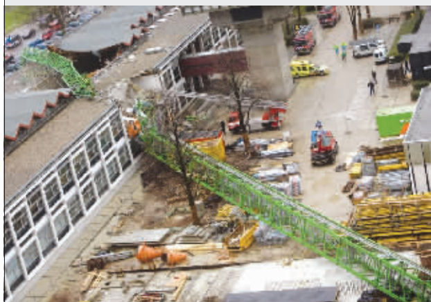
在荷兰,高达80米的起重机被风吹倒
