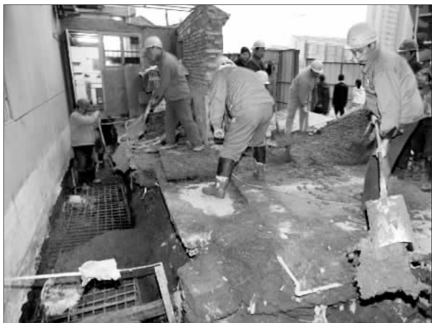
昨天,工人们正在加固墙体 快报记者 施向辉 摄
