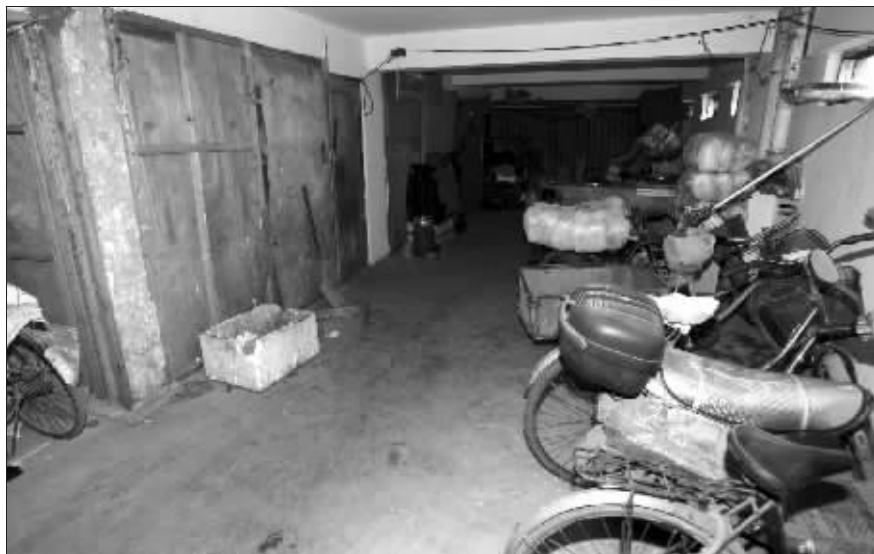
南京银城街小区出新难,地下自行车库被隔挡成简易房,出租给了外来人员。
