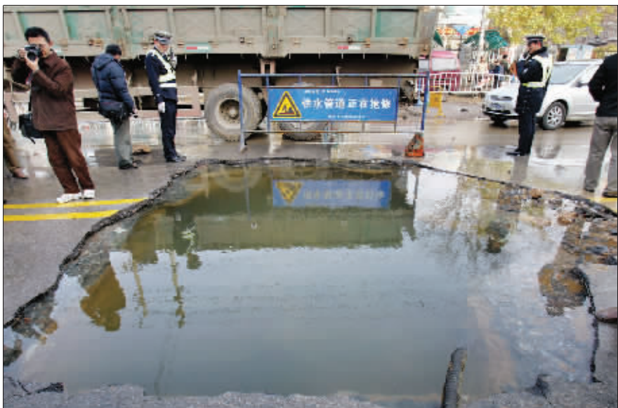
爆管处就在这个直径4米的大坑里 快报记者 施向辉 摄
