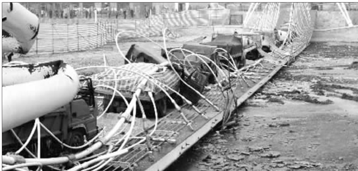
悬索大桥坍塌后,桥上10辆用于测试的卡车随桥身坠入河道,严重损毁
